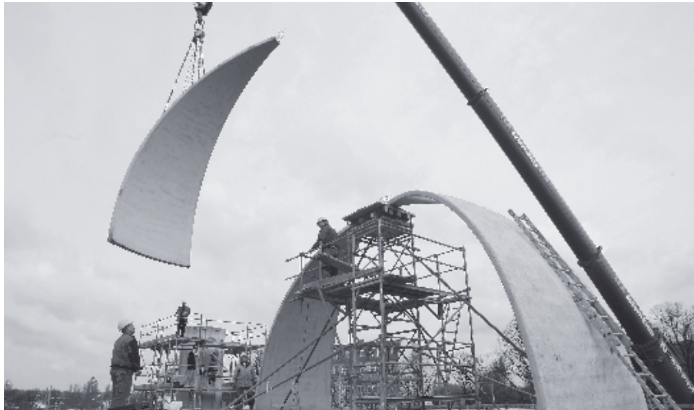
Bau der Khadija-Moschee in Berlin-Heinersdorf
